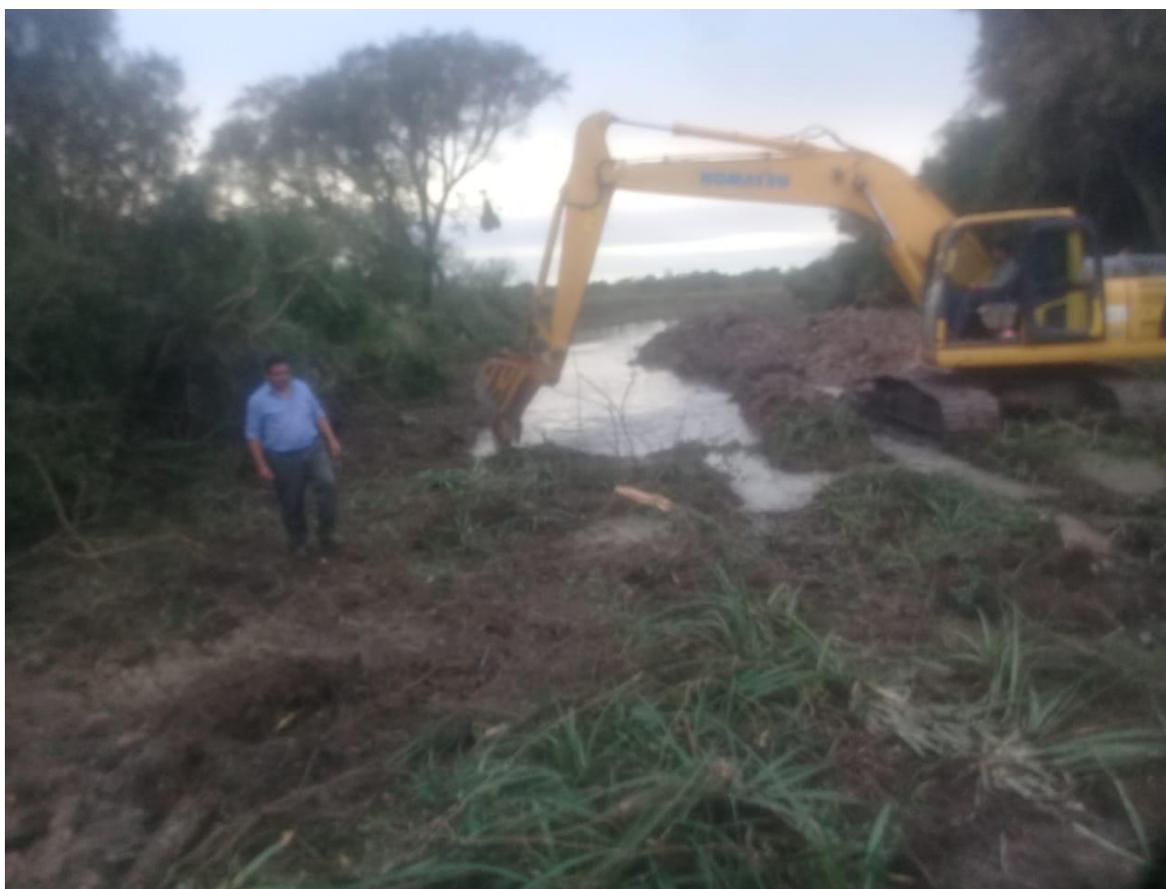
Simultáneamente una retroexcavadora a oruga trabaja en la canalización para aliviar los excesos pluviales.
