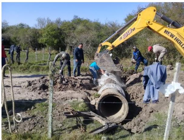
En esa zona rural, personal de esa repartición que conduce Gustavo Gabiassi construyó tres cruces de caminos con el alcantarillado de caños de hormigón armado de 600 y 1000 mm de diámetro.
