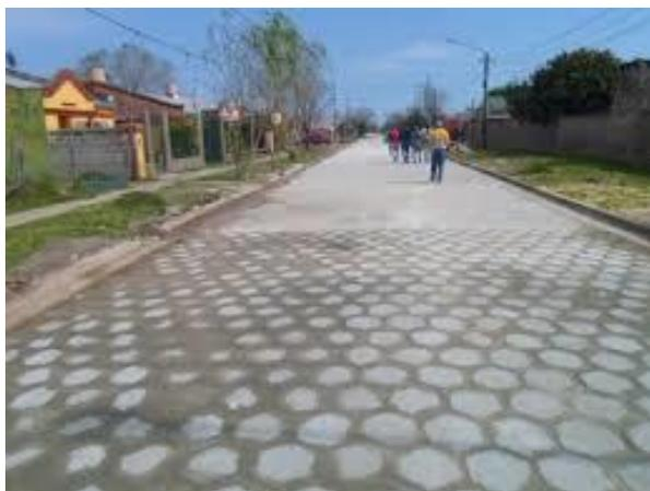
El adoquinado se realizó con material octogonal de cemento en un tramo de 200 metros, que se completaron y se corresponde a un programa que se lleva adelante entre municipio y vecinos.
