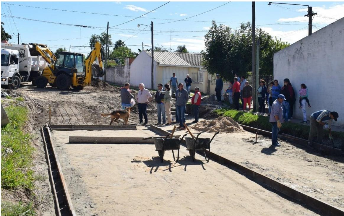
La primera etapa comprende el asfaltado de dos cuadras, donde se colocaron previamente los sistemas pluviales con caños PEAD, cámaras de registro y conexiones domiciliarias de agua potable y, en pocas horas, se procederá a volcar el hormigón.
