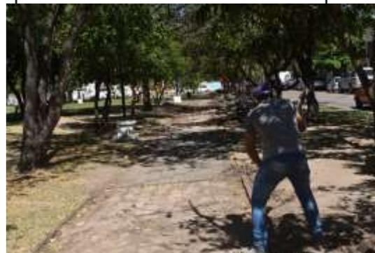
Este viernes la mayoría de las baldosas han sido retiradas y deberán ser reemplazadas porque muchas estaban desniveladas, y en otras partes algunas raíces de los árboles levantaban la vereda y allí quedaba depositada el agua lo que aceleraba el deterioro.
