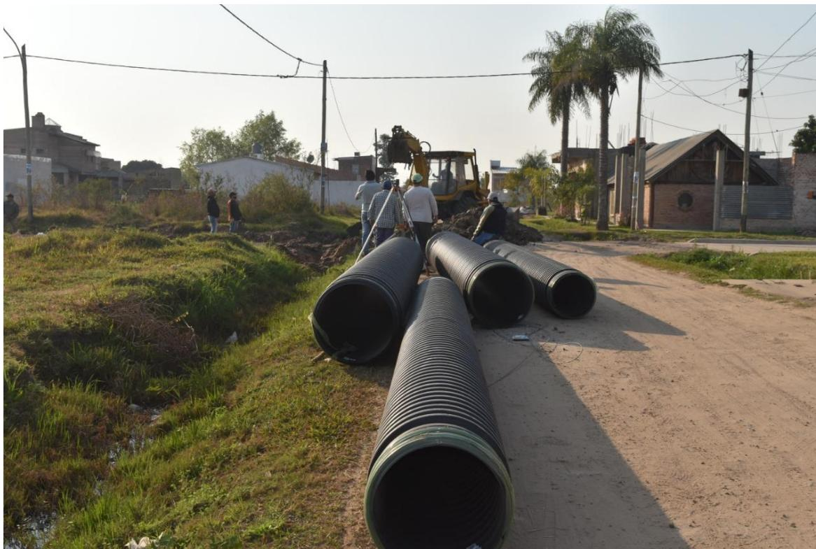
El encargado de obra explicó que “se repusieron caños de PVC (Polipropileno de alta densidad de 600), haciendo el cruce transversal a la calle Jujuy, por Gerardo Pando; de un lado caño de 600 y del otro de 45, sacando los caños viejos de hormigón, deteriorados, reponiendo por estos de PVC de alta densidad”.
