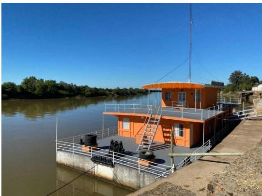
La estructura en su parte inferior es totalmente de cemento y, a pesar de los años, está en muy buenas condiciones de flotabilidad y sin fisuras en sus compartimientos estancos.
