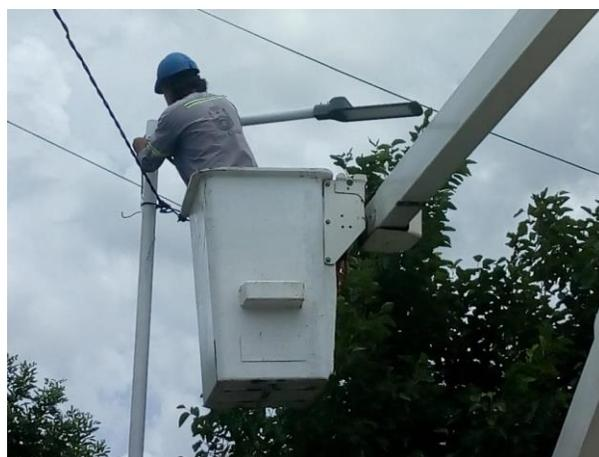
Además, se procedió a la colocación de cableado en una extensión de más de 600 metros. Los operarios de Luminotecnia avanzaron en el tendido de cable pre ensamblado de 2 por 16 milímetros.
