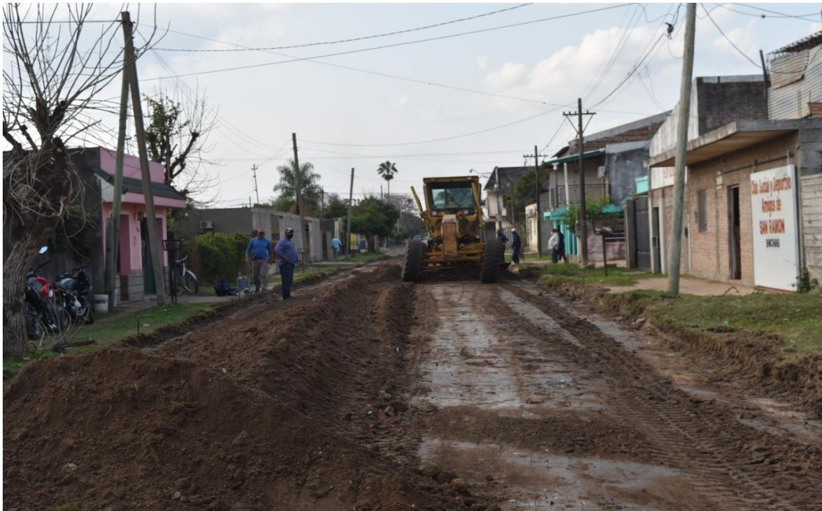
Este jueves, personal de Obras Públicas se hizo presente en la zona Este de Goya para arrancar con los trabajos de una nueva obra de pavimentación mediante movimientos de suelo, apertura de caja y base de arena cemento. Habitualmente, previamente a la pavimentación de una calle se debe realizar el trabajo de apertura de caja y reparación de suelos, procediéndose si fuera necesario al recambio de cañerías de agua y la colocación de suelo cemento.
