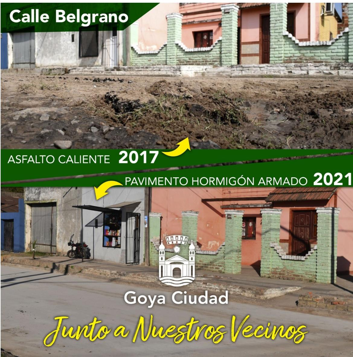
El Municipio intervino para concretar esta obra en hormigón armado, que tiene un espesor de 18 centímetros, lo que garantiza la calidad del trabajo. De esta manera la actual administración municipal rectifica el mal trabajo realizado en el 2017 durante la gestión anterior, cuando se hicieron las obras con la Unidad Asfáltica Municipal Vial Goya
