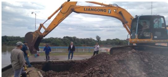
En el lugar se iniciaron los trabajos de reparación en losas contiguas al muelle y galpón en el sector Prefectura Goya. Dichos trabajos consisten en retiro de losas y
