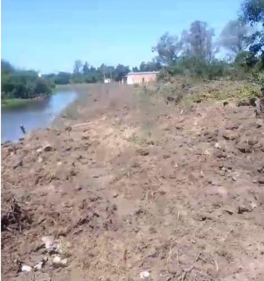
Personal y equipamiento del PRODEGO realizaron limpieza de 6 km del canal Sur, este conducto evacua las aguas de lluvia del sector Este de la ciudad a través Estación de Bombeo Circunvalación. Este canal con sentido Este – Oeste, descarga los excedentes pluviales en el Arroyo y bañados del Carumbé.
