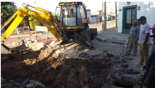
El hundimiento del pavimento de la bocacalle Entre Ríos y José E. Gómez donde se produjo la rotura y hundimiento del pavimento como consecuencia de averías del conducto pluvial de diámetro 800 mm, asentamiento y rotura de cámara de líquidos cloacales.
