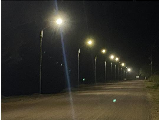
Recientemente se finalizaron los trabajos del nuevo alumbrado público en el camino del canal de Chiappe, en todo este sector se procedió a la instalación de un nuevo sistema de iluminación, instalación del tendido, la colocación de columnas y sus correspondientes luminarias. Este tendido comprende desde avenida Alem hasta la costa, para empalmar con costanera norte. La obra del nuevo tendido de iluminación en este acceso, se inaugurará la próxima semana.
