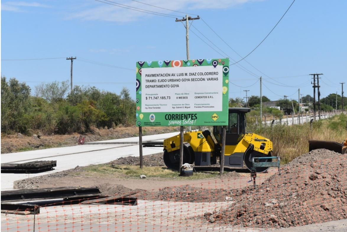
En esta Avenida, se construyeron 770 Metros de pavimento en hormigón armado, es una obra que contempla, las dos calzadas con un parterre en medio, con el correspondiente cordón cuneta, que se complementan con las obras de nueva iluminación, del alumbrado público y las complementarias de saneamiento, construcción de pluviales.
