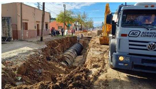
Los trabajos realizados en esa arteria consistieron en el reemplazo de los caños de hormigón armado de 1.600 mm en el tramo del pluvial que presentaban anomalías en su estructura y desplazamientos de juntas, en una longitud de 16 m., por tubos de hormigón armado de igual diámetro. Los mismos son revestidos de geotextil y sellado de juntas y recubiertos por arena cemento para luego proseguir con
