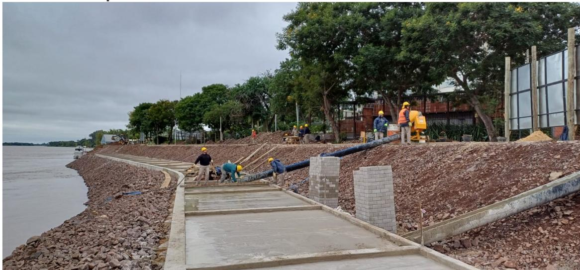
A buen ritmo avanzan los trabajos de la obra de la Nueva Costanera de la ciudad. Se trabaja en distintos componentes del sistema de defensa fluvial. A) recubrimiento estructural del pedraplén de roca basáltica, B)
