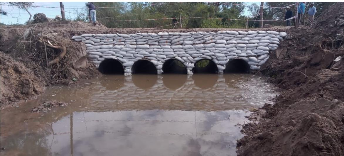
Se colocó una batería de 5 caños de 6 m cada uno, de material polietileno de alta densidad, relleno y compactación del suelo de tapada y rodamiento.
