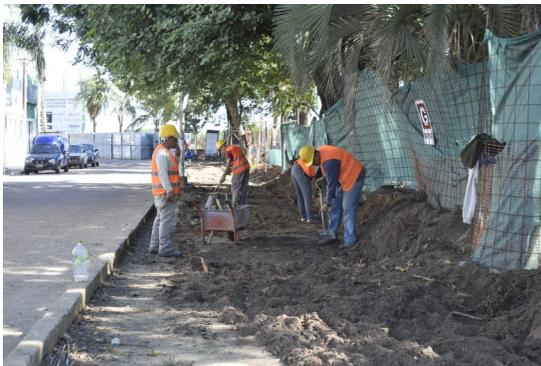
En la continuidad de las acciones de puesta en valor y construcción de nueva costanera de Goya, prosiguen los trabajos de instalación del sistema de desagües de la microcuenca del sector de plaza Italia.
