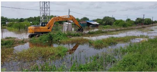
Las obras en curso se centran en la rectificación de las defensas afectadas, trabajos cruciales para restaurar la estabilidad y prevenir futuros problemas derivados de la erosión. La excavadora, con su capacidad y precisión, se ha convertido en una herramienta esencial para llevar a cabo estas tareas de manera eficiente. Además, desde ayer (miércoles) se ha instalado una bomba eléctrica
