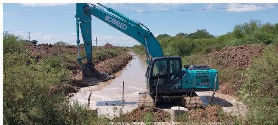
**En el marco de los trabajos programados en la zona, en dicho barrio se realiza alcantarillado con conductos PEAD de 400 mm de diámetro con el propósito de**
