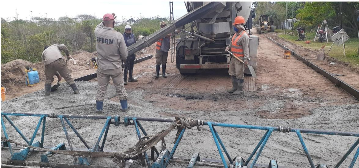
En obras por administración, y dentro del convenio de colaboración con el gobierno provincial, prácticamente se cumplimentó la primera cuadra de pavimento en hormigón armado de calle Evaristo López. Este trabajo en construcción a nuevo consta de sacar el material sobrante del asfalto negro del pavimento anterior, que no dio resultado y se encontraba en mal estado.
