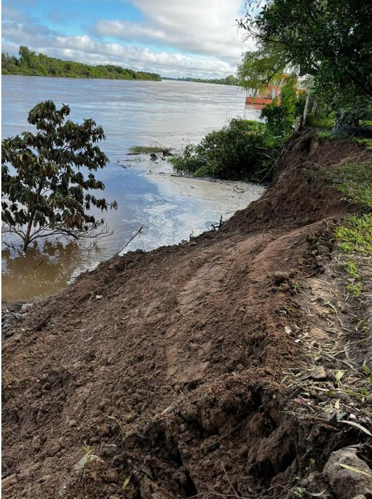
**El PRODEGO con el apoyo de máquinas va rompiendo la barranca a pique, luego del deslizamiento, para ir controlando el derrumbe y luego volcar el material.**
