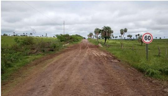
La mencionada bajada del Cocalito, vital en la conexión vial entre la RN12 y la RP 84, se vio afectada por el socavamiento de media calzada, generando preocupación por la seguridad del tránsito vehicular. El acceso al paraje “El Cocalito” y áreas circundantes se vio interrumpido debido a la necesidad de realizar trabajos de reparación urgentes.
