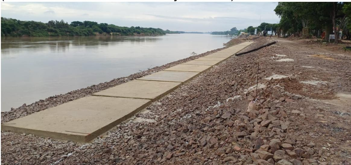
En este trabajo se continúa con los componentes referentes a la infraestructura eléctrica y pluvial como así también con el sistema sanitario y el componente estructural sobre el pedraplén de piedra basáltica en una longitud de 500 m.
