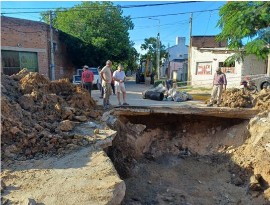
Este socavamiento que produjo el hundimiento de la calzada es resultado del desprendimiento y rotura del pluvial de la calle Mitre que conecta al conducto principal ubicado por Av. Madariaga.
