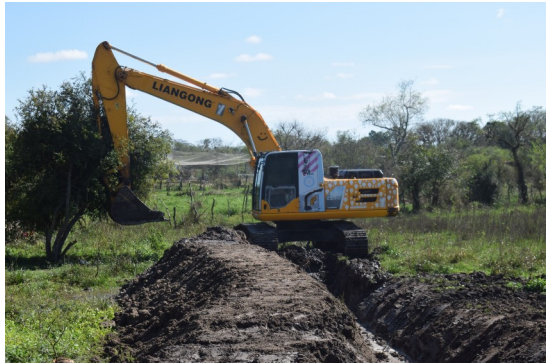
LIMPIEZA Y MANTENIMIENTOS DE CANALES A CIELO ABIERTO
