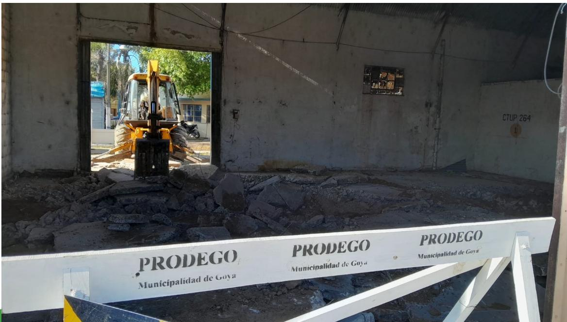
Actualmente, los trabajos están abocados al saneamiento del sector, afectado por hundimientos en el terreno. Esta intervención es necesaria antes de proceder a la reposición de la losa de hormigón, etapa fundamental para garantizar la estabilidad y durabilidad de la estructura.
