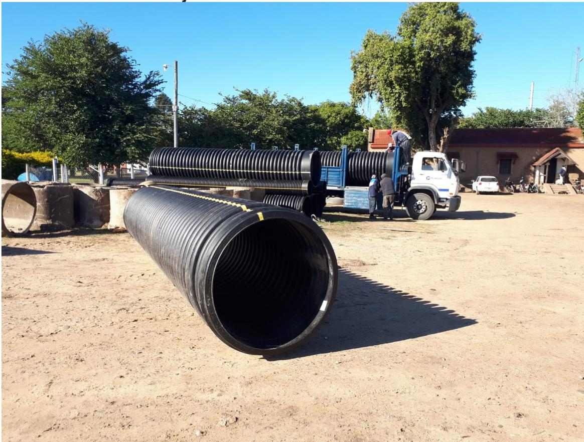
La obra consiste en la elaboración de una alcantarilla de una batería de 5 tubos PEAD, de 1000 mm de diámetro; en la jornada del viernes el personal del PRODEGO, comenzaron con los trabajos de desvío y bypass, en el Canal Principal Sur.
